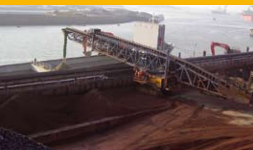
65 METER MOBIELE TRANSPORTBAND OP RUPSEN TEN BEHOEVE VAN ERTS- OVERSLAG BIJ STAALFABRIEK IN IJMUIDEN, CAPACITEIT 3000 TON PER UUR
