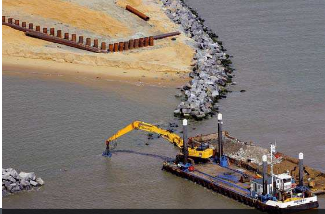
ABEKO SERVER 3 CON KOMATSU PC800 COLOCANDO ESCOLLERA DE 6 – 10 TONELADAS EN YARMOUTH (REINO UNIDO)
