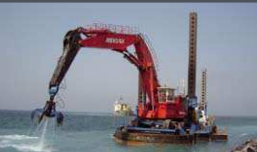
ABEKO SERVER 1 CON TEREX O&K RH90 PERFILANDO ESCOLLERA DEL NUEVO ROMPEOLAS EN RAS LAFFAN (QATAR)
